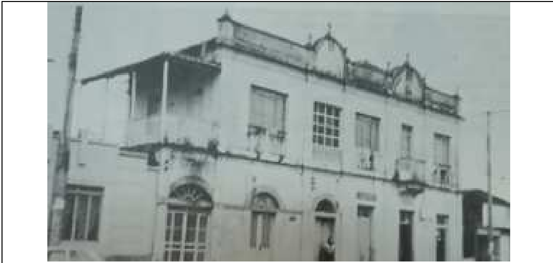
Figura 2 – Imagem da edificação constante no IPAC do IEPHA de 1985.
