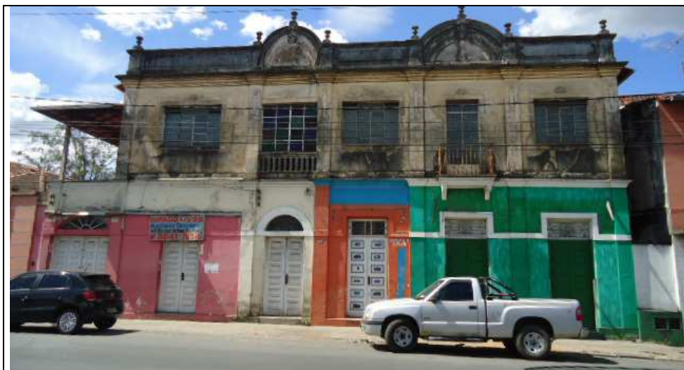
Figura 3 – Fachada frontal em 2014.
