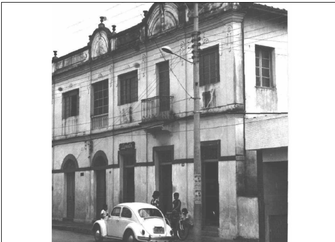
Figura 1 – Imagem da edificação constante no relatório da PLAMBEL, 1976.
