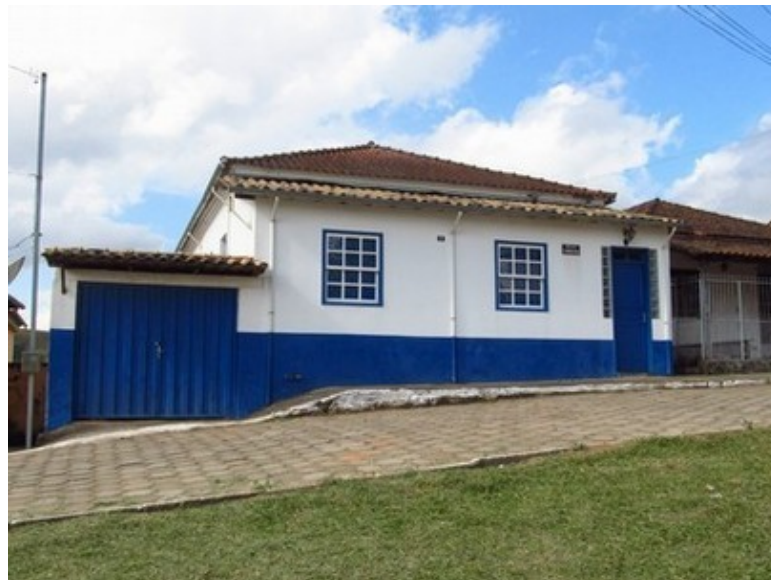
Figuras 1 e 2- Imóvel da Rua Padre Antônio B. de Freitas, nº 06, em Santa Rita do Ibitipoca. Fotos da vistoria realizada em 24/07/2018.
