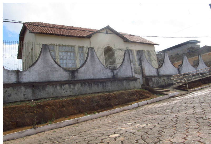
Figura 1e 2- Edificação na Rua Joaquim da Fonseca, nº 218, em Santa Rita do Ibitipoca. Foto da vistoria realizada em 24/07/2018.
