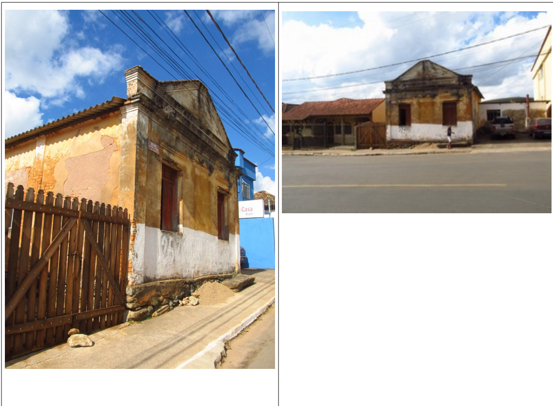
Figuras 1 e 2- Imóvel na Rua Joaquim Ribeiro de Paula, nº 23, em Santa Rita do Ibitipoca. Fotos da vistoria realizada em 24/07/2018.
