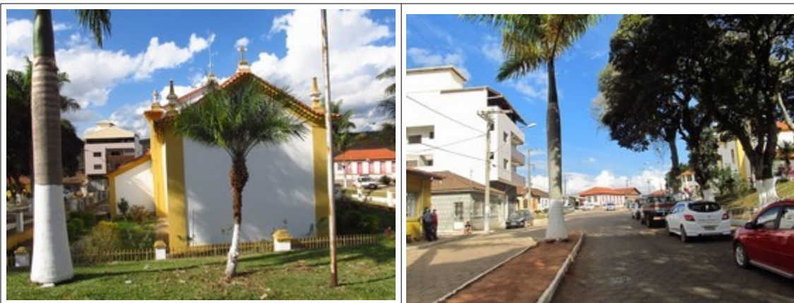
Figuras 8 e 9- Construção de um prédio no entorno da Igreja Matriz em Santa Rita de Ibitipoca causa descaracterização no conjunto. Fotos da vistoria realizada em 24/07/2018.
