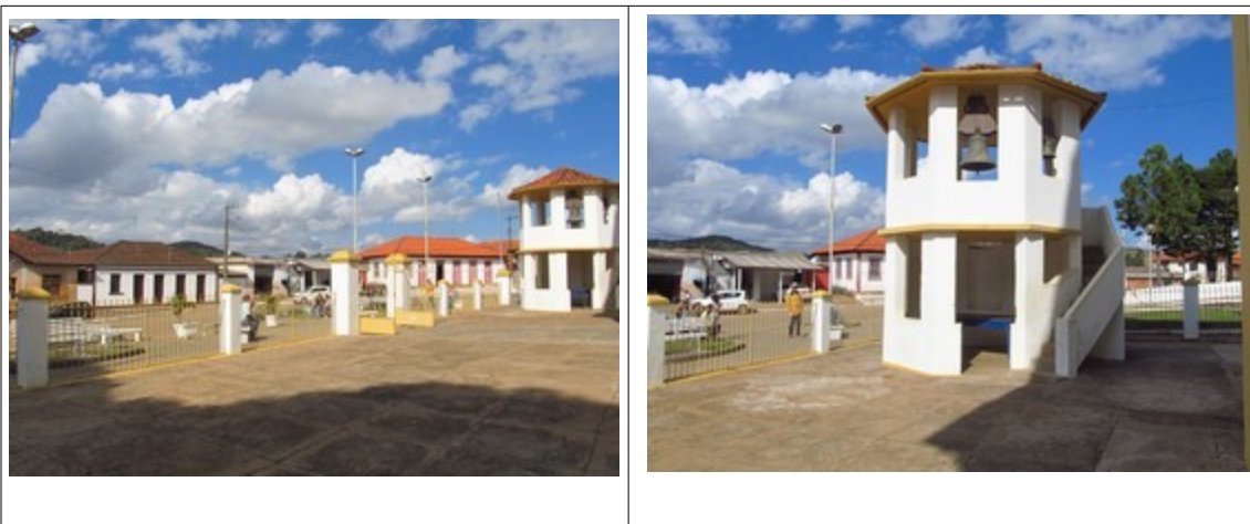
Figuras 5 e 6- Torre Sineira implantada no adro da Igreja Matriz de Santa Rita. Fotos da vistoria realizada em 24/07/2018.
