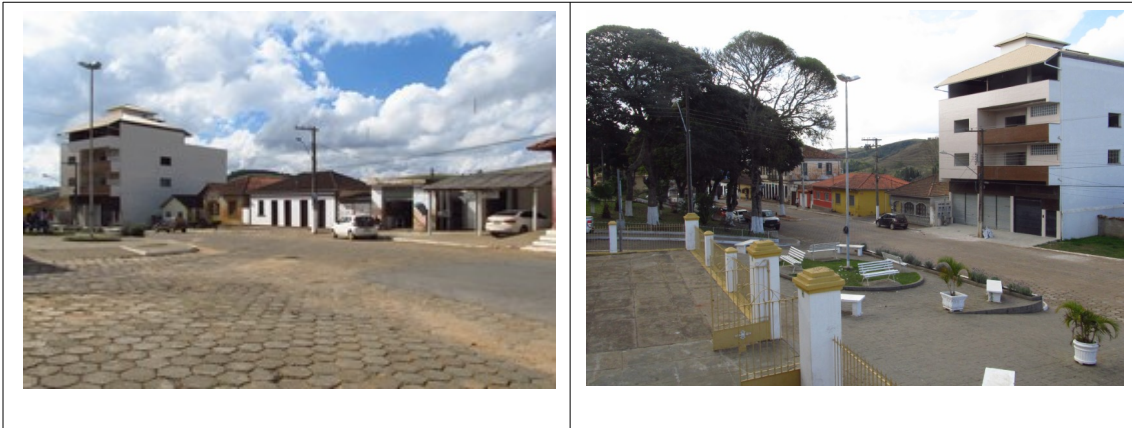
Figuras 10 e 11- Construção de um prédio no entorno da Igreja Matriz em Santa Rita de Ibitipoca extrapola altimetria dominante no conjunto. Fotos da vistoria realizada em 24/07/2018.
