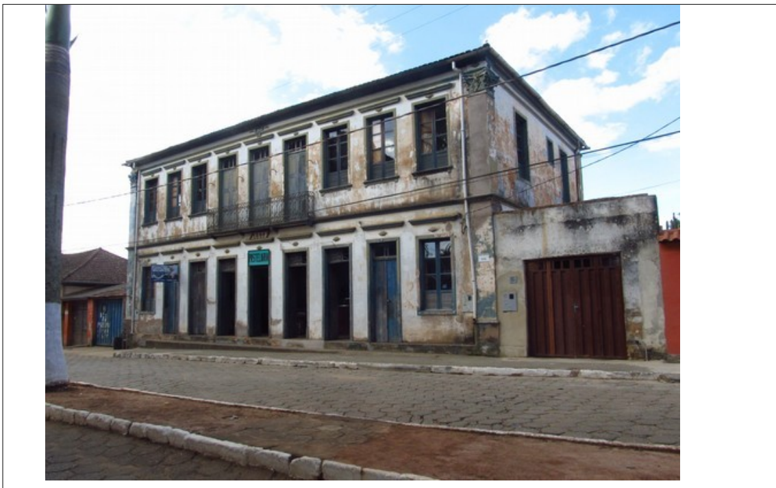
Figura 1- Casarão em Santa Rita do Ibitipoca. Foto da vistoria realizada em 24/07/2018.
