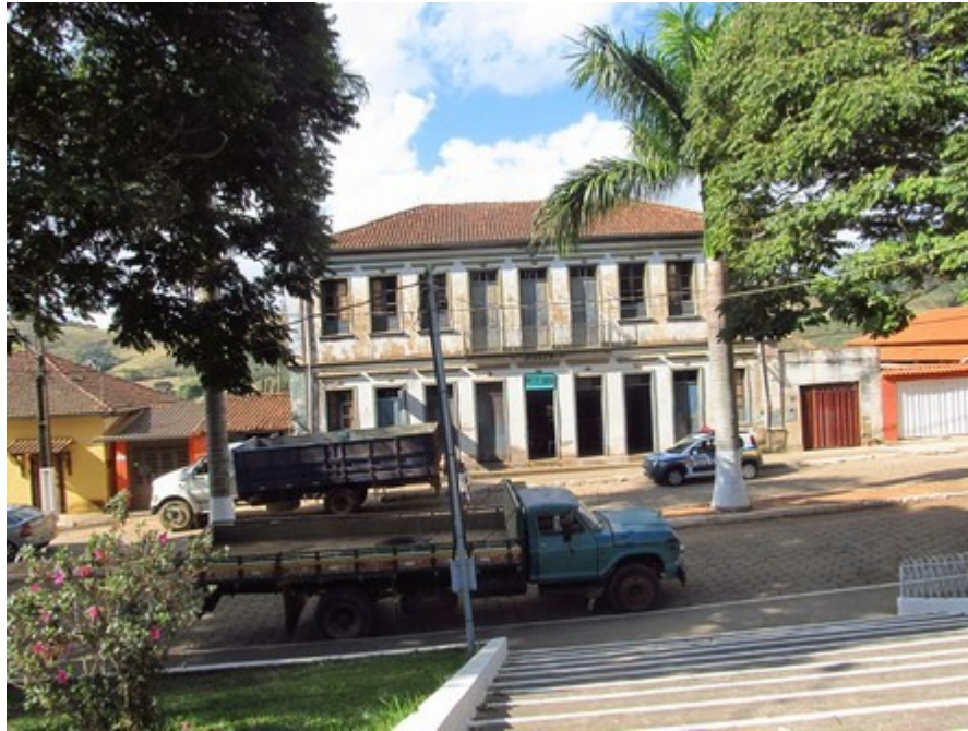
Figura 2 - Casarão em frente à Praça Joaquim Ribeiro de Paula, em Santa Rita do Ibitipoca. Foto da vistoria realizada em 24/07/2018.
