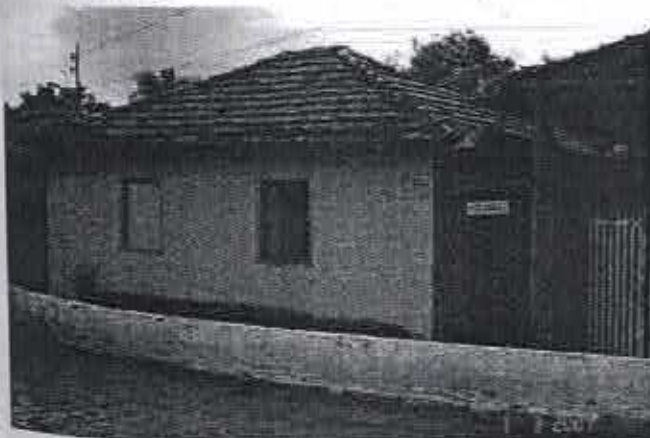
Foto 044: Residência em estilo Colonial, localizada na Av. Minas Gerais, nº 770, entre as Ruas Canal e Paranaíba.
