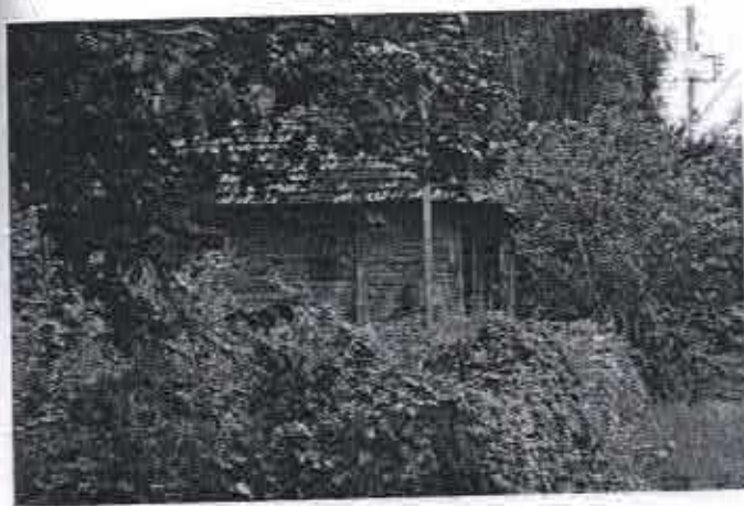
Foto 077: Edificação residencial de feições coloniais localizada na Rua 4, Município de Santa Vitória, distrito de Perdilandia. Fonte: Bruna Quick – Fev/2007.
