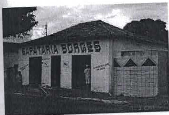
Foto 031: Edificação de feições coloniais, localizada na R. Canal, nº227, entre as Avenidas Genésio Franco de Moraes e São Paulo. Fonte: Bruna Quick – Fev/2007
