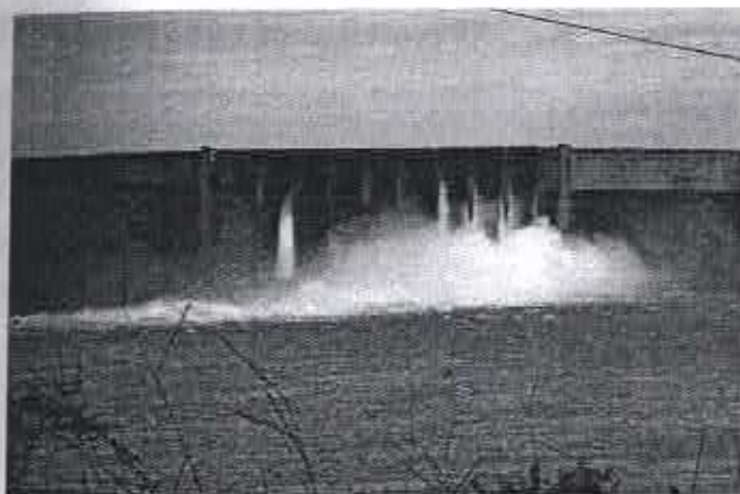
Foto 093: Usina hidrelétrica de São Simão, com as comportas abertas. Município de Santa Vitória, Zona Rural. Fonte: Bruna Quick – Fev/2007.
