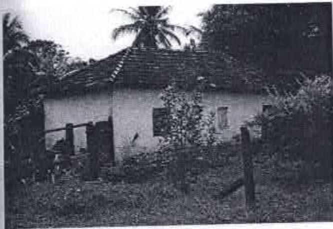
Foto 076: Edificação antiga localizada na Rua 4, Município de Santa Vitória, distrito de Perdilandia. Fonte: Bruna Quick – Fev/2007.
