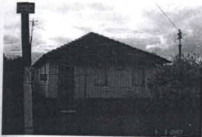
Foto 036: Residência de feições Colonial, localizada na Av. Genésio Franco de Moraes, nº 352.
