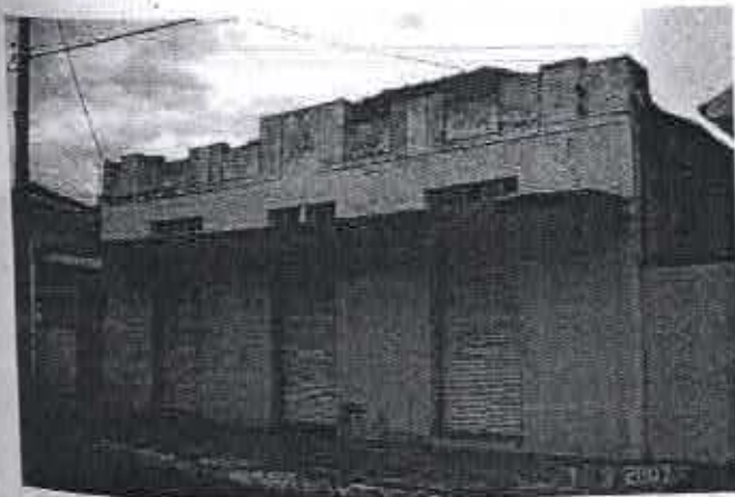
Foto 026: Edificação Eclética, de propriedade do Sr. Ari de Souza Oliveira, localizada na Av. São Paulo,
