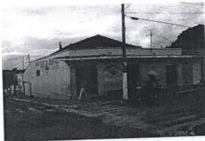
Foto 033: Edificação localizada na esquina da Av. São Paulo com R. Canal.
