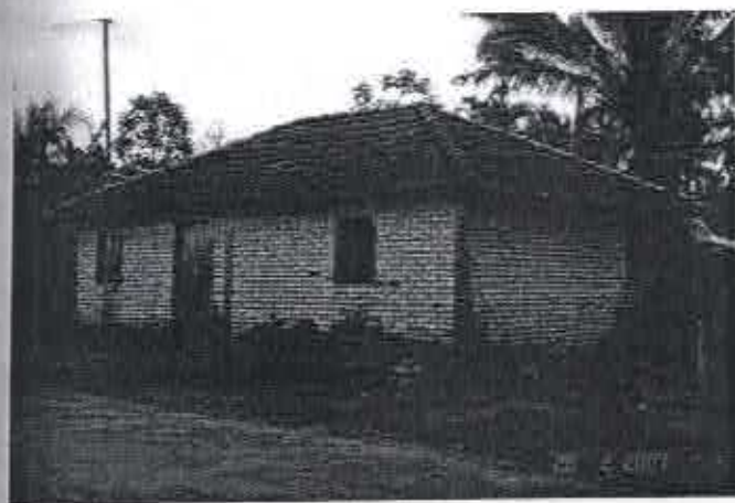
Foto 070: Edificação antiga localizada na Rua 10. Município de Santa Vitória, distrito de Perdilândia. Fonte: Bruna Quick – Fev/2007
