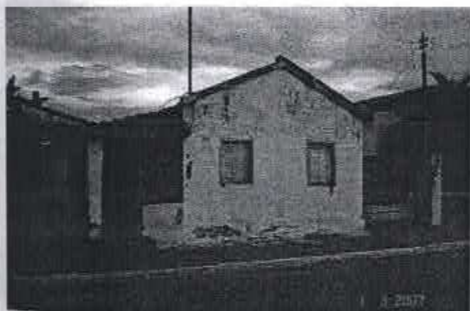
Foto 049: Residência de feições coloniais, localizada na Av. Minas Gerais, nº 1057. Fonte: Bruna Quick – Fev/2007
