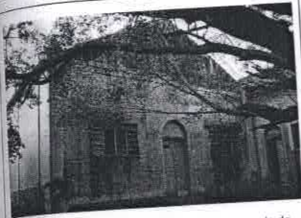
FOTO 05: Fachada Frontal do anexo esquerdo da igreja. Verifica-se o descuido com a edificação, que apresenta manchas de umidade nas paredes, pintura descascando e vários vidros quebrados nas janelas. Av. Genésio Franco de Moraes, s/nº - centro - Santa Vitória/MG Fev/2007
