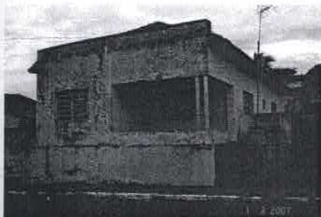
Foto 018: Edificação com feições ecléticas, localizada na Av. São Paulo, próximo à R. Matriz.
