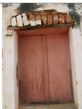
Figura 15- Detalhe da janela e do sistema
