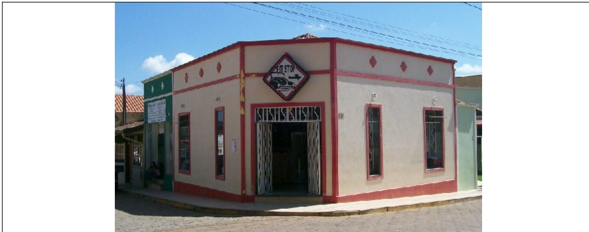
Figura 13- Fachada de imóvel comercial.
