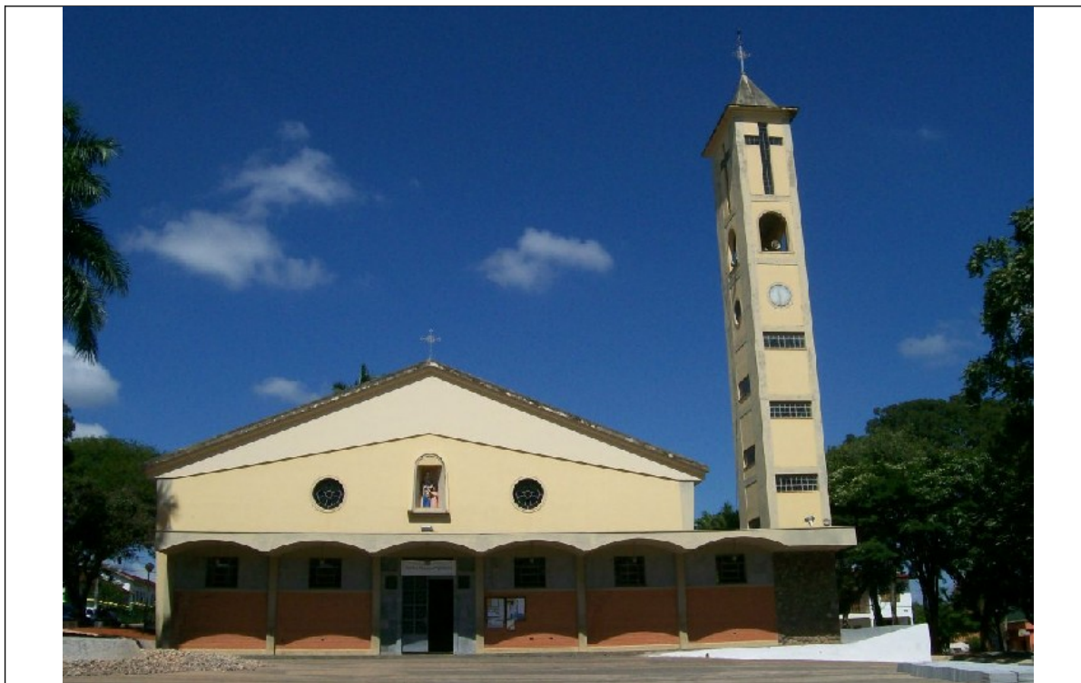
Figura 05- Igreja Matriz de Santana da Vargem. Fotos da vistoria realizada em 19/04/2012.
