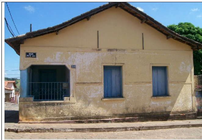
Figura 06 – Fachada Principal da residência.
