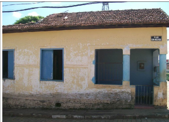
Figura 07 – Fachada lateral do imóvel.
