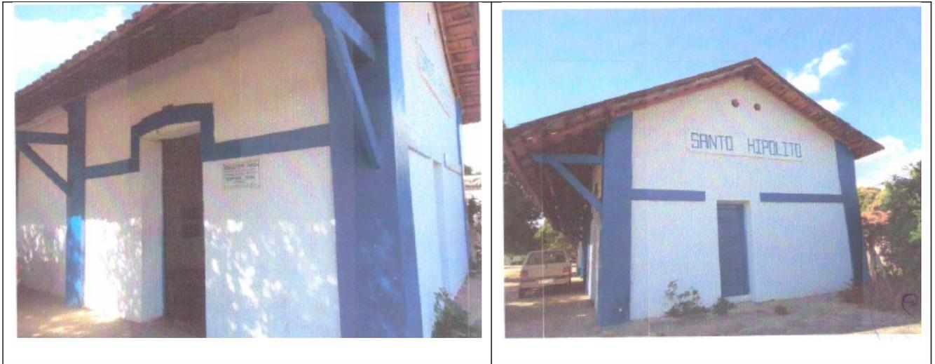
Figuras 06 e 07 – À esquerda, fachada principal. À direita, fachada lateral direita com detalhe para a presença de umidade na parte inferior da alvenaria.
