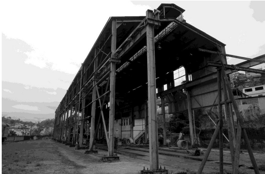
Figuras 1 e 2- Localização do Quarto Depósito, com a indicação do antigo Galpão de Revisão da RFFSA e vista deste antigo galpão. Fonte http://portal.iphan.gov.br/uploads/ckfinder/arquivos/VI_coloquio_t2_uma_nova_perspectiva.pdf .
