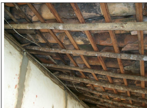
Figura 14 – Cobertura e emendas na alvenaria.
