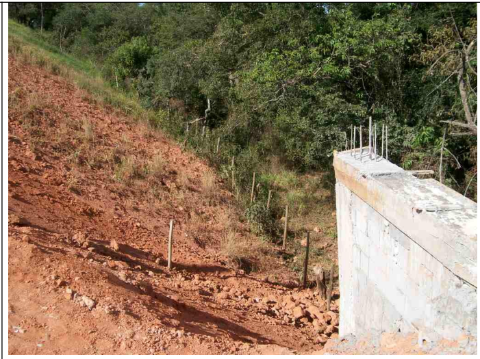
Figura 12 – Muro de arrimo construído na área de entorno de tombamento.
