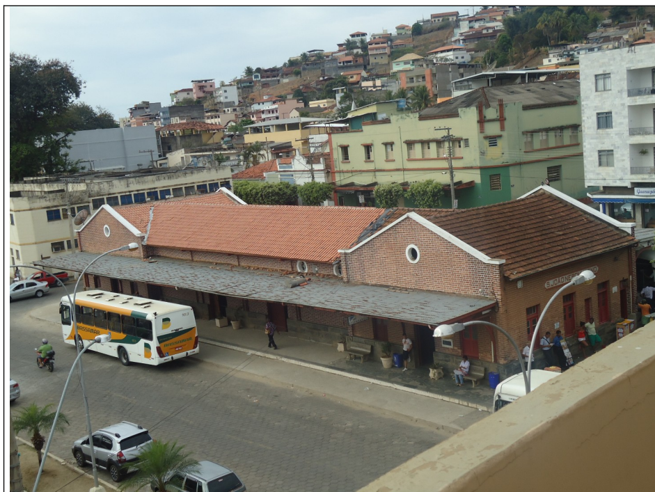
Figura 21 – Troca das telhas da cobertura.
