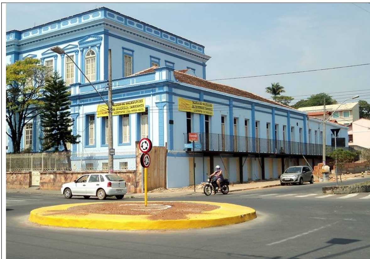
Figura 08 – Imagem atuais do bem cultural, em obras. Fonte: Conselho Municipal
