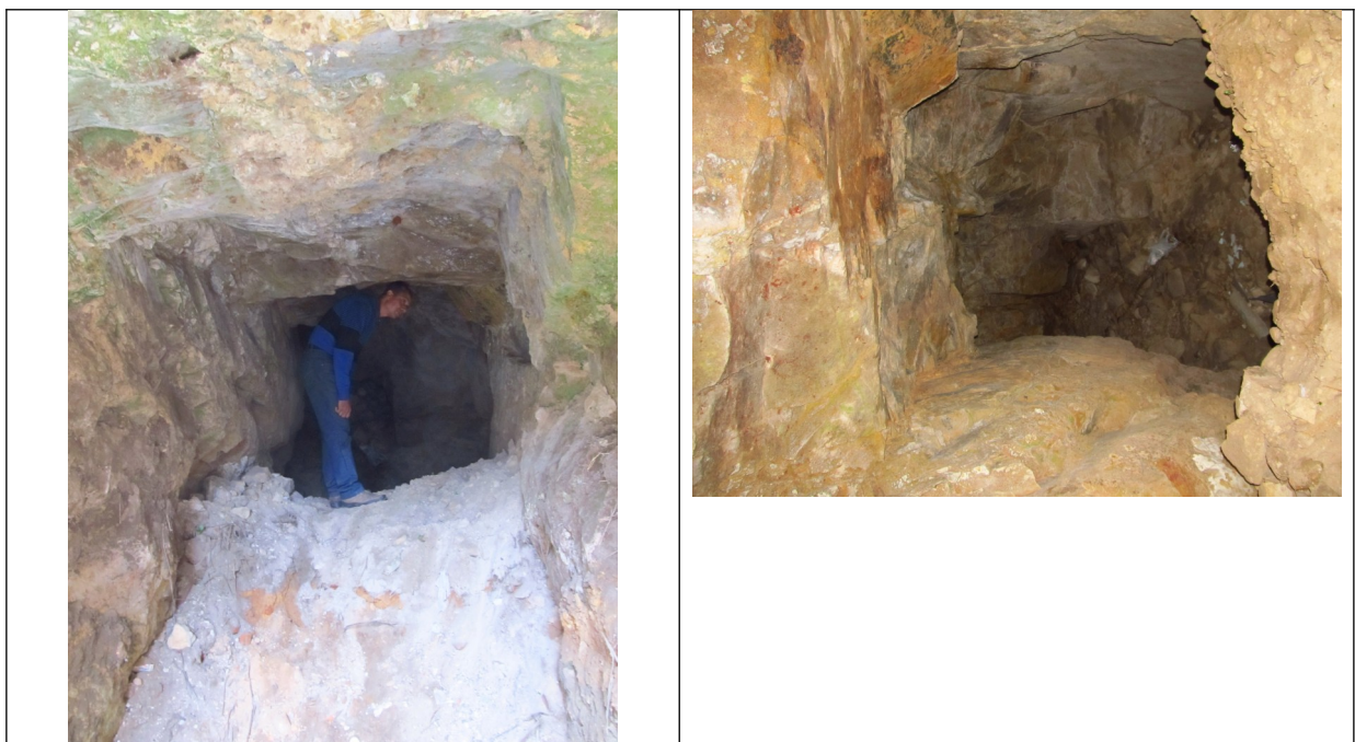
Figuras 19 e 20- Beta n° 2, com detalhe do seu interior. Fotos da vistoria realizada em 22-07-2015.
