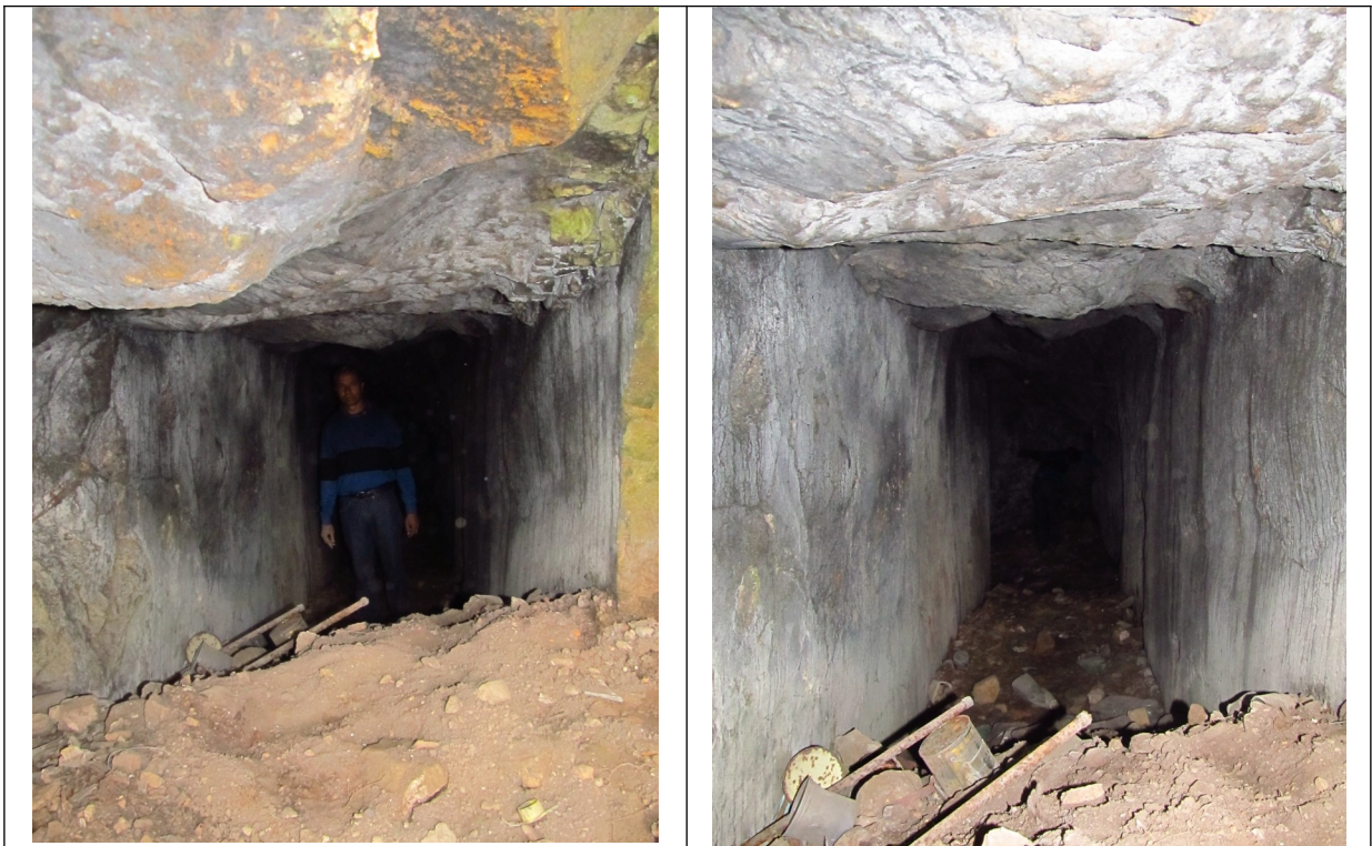
Figuras 23 e 24- Interior da beta nº 4. Fotos da vistoria realizada em 22-07-2015.
