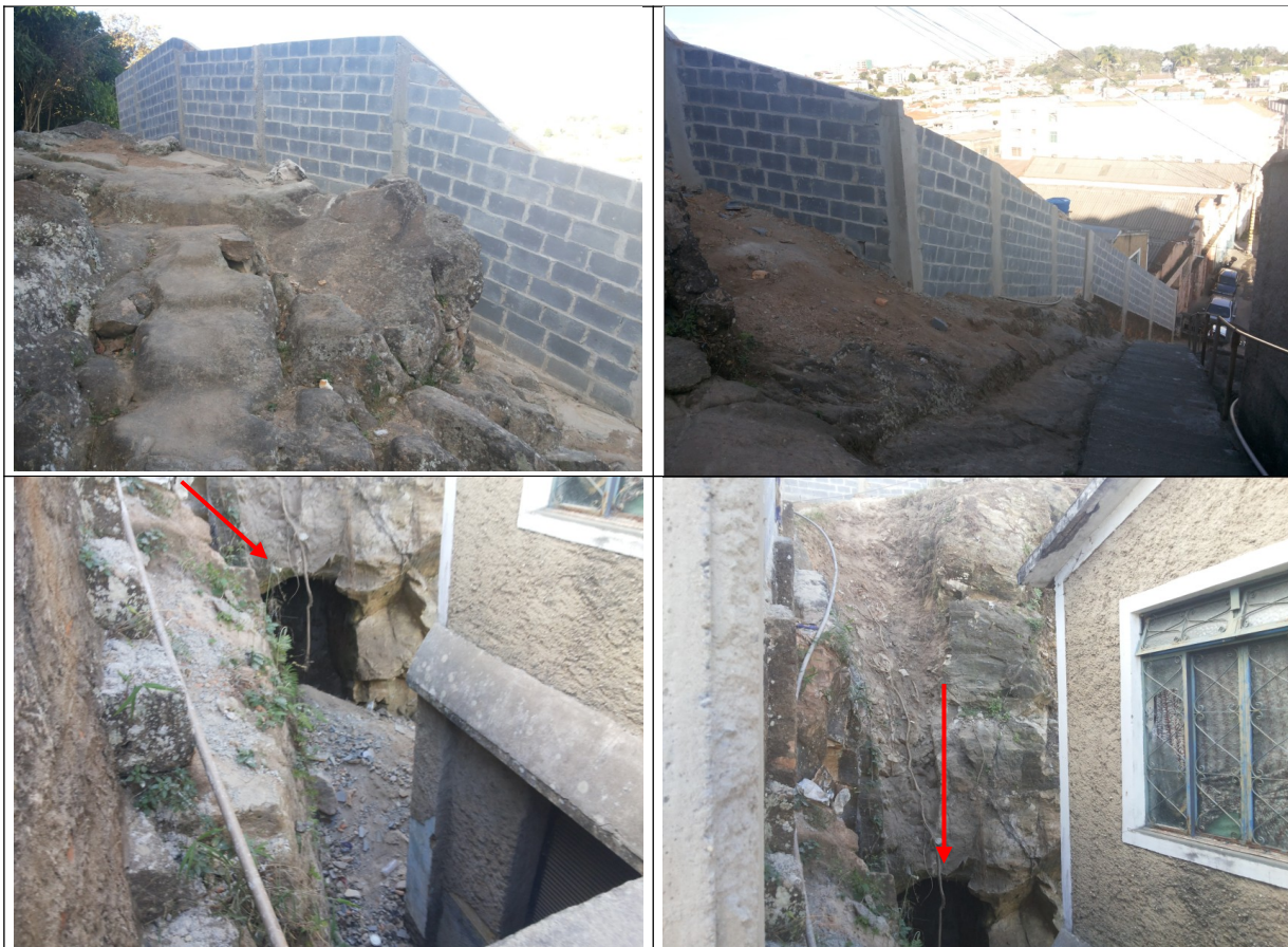
Figuras 02, 03, 04 e 05- Fotografias do terreno da Rua Aureliano Raposo, n° 09, Centro- São João Del Rei. Nas duas últimas aparecerem as betas.
