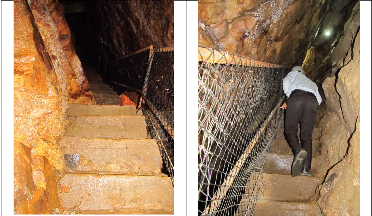
Figuras 33 e 34- Estruturas construídas na “beta turística” para possibilitar a visitação: escadas e corrimão. Fotos da vistoria realizada em 22-07-2015.
