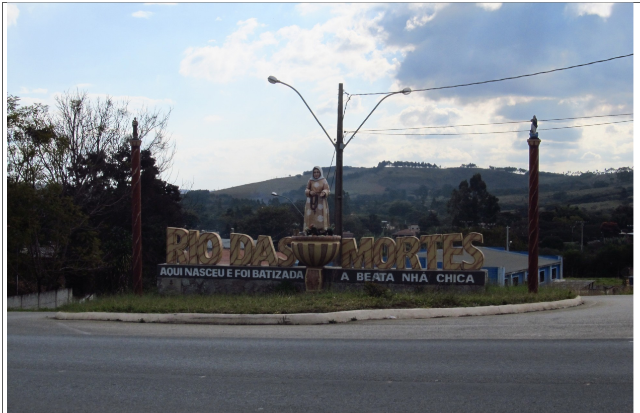
Figura 14 – Trevo de acesso ao Distrito de Rio das Mortes Pequeno. Foto da vistoria 22-7-2015.
