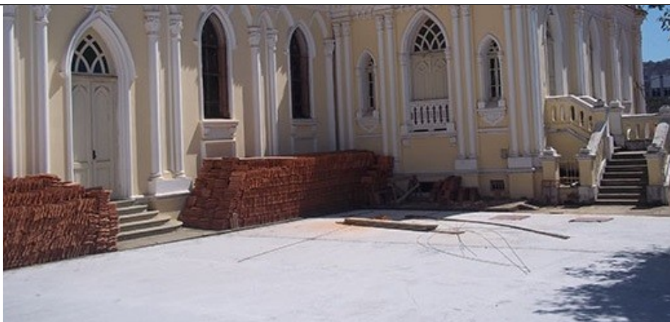
Figura 08 – Pátio da Santa Casa ao lado da Capela após a obra de retirada do jardim e construção de estacionamento. Fonte: http://www.gazetadesaojoadelrei.com.br/site/2013/08/jardins-da-santa-casa-terao-que-ser-repostos/ . Acesso em dezembro/2014.
