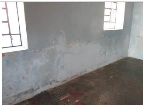
Figura 10 – Umidade ascendente e danos no piso.
