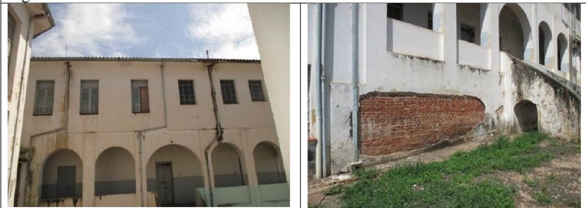
Figura 05 – Fachada dos fundos, com tubulação exposta e manchas de umidade.
