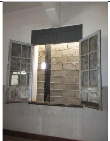
Figuras 17 e 18 - Obra no perímetro de entorno de tombamento do prédio, muito próxima a este, prejudicando a iluminação e ventilação de uma das salas e podendo comprometer a conservação e ambiência do bem tombado.
