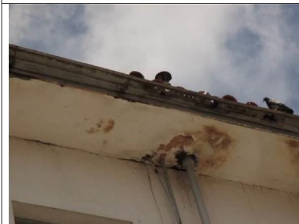
Figura 09 – Manchas de umidade junto aos elementos de drenagem de água pluvial.
