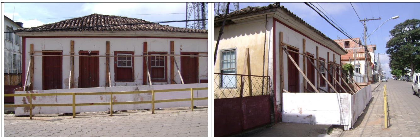
Figuras 3 e 4 – Vista da fachada com escoramento e vedação em tapumes.
