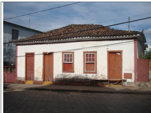
Figura 01 – Fachada do imóvel em análise. Fonte: Laudo nº 37/2013 Promotoria de Patrimônio Cultural.
