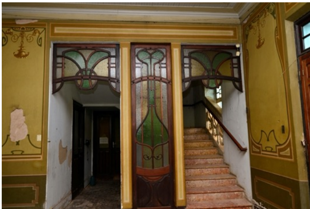
Figura 57: Paineis art nouveau visto na entrada principal, no 1º piso do Palacete de José Caetano Borges, Uberaba, MG.
