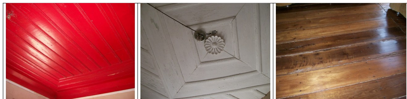
Figuras 29 e 30 – Forros de madeira.
