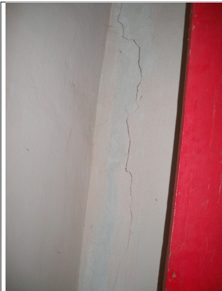
Figura 18 – Trincas.
