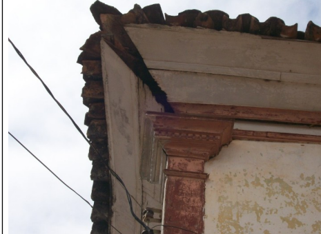
Figura 13 – Cimalha comprometida.
