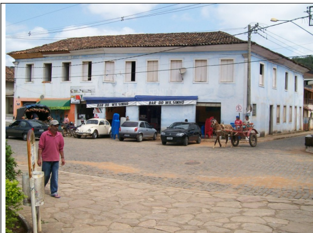
Figura 07 – Fachada principal da edificação.
