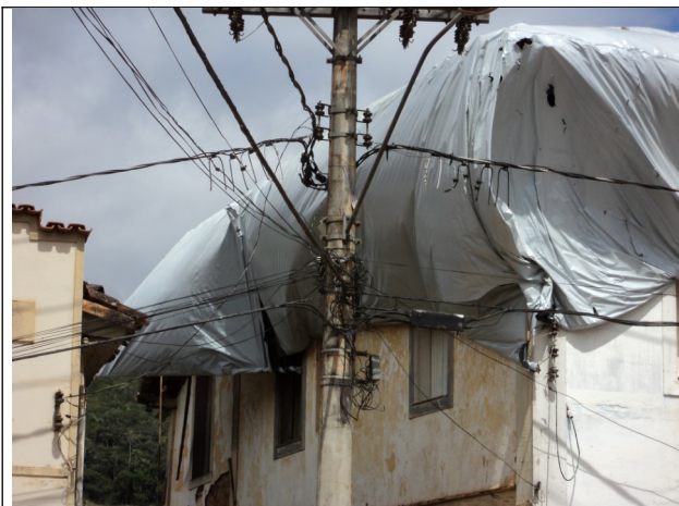
Figura 02 – Vento incidindo na lona
