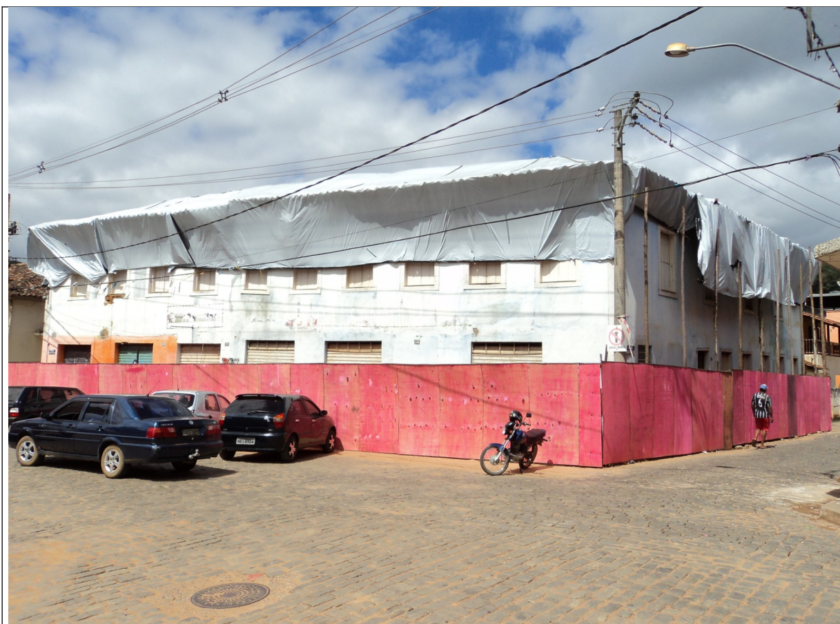
Figura 01 – Colocação e tapumes e lona sobre a cobertura.
