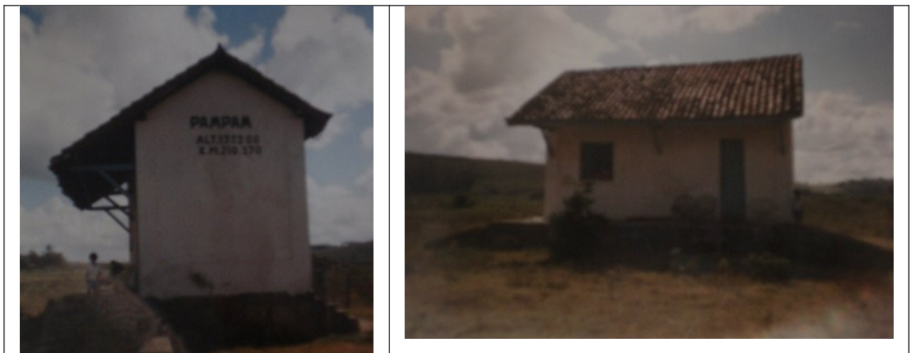
Figuras 06 e 07- Estação Ferroviária de Pampam antes da demolição em 1995. Fonte: www.estacoesferroviarias.com.br
