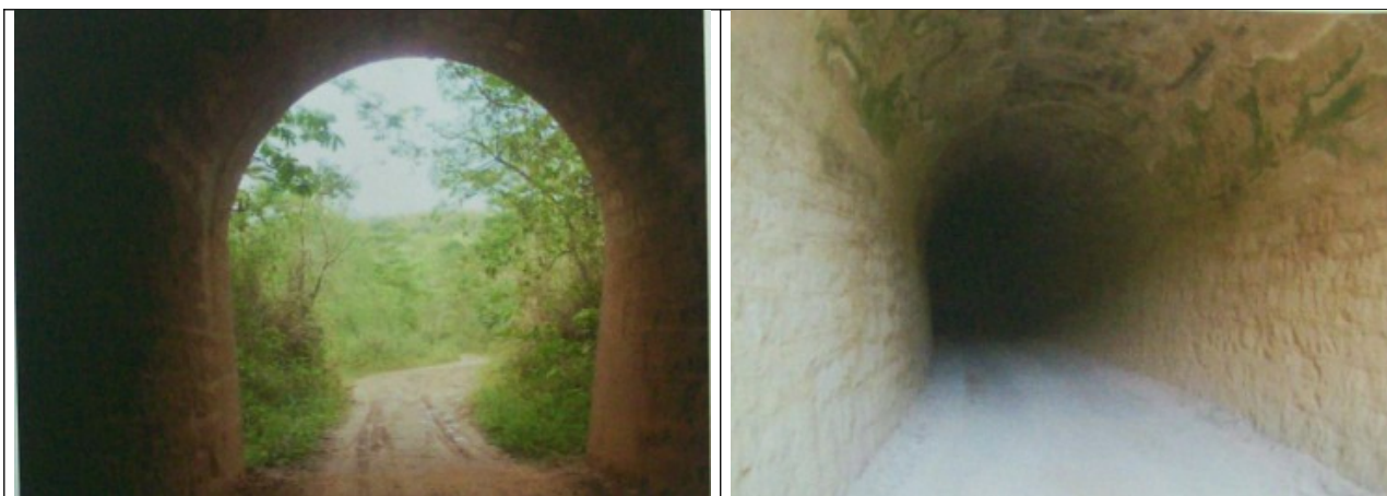
Figuras 27 e 28- Túnel da antiga estrada de Ferro Bahia-Minas- Túnel A da Turma 38- Km 09, bem tombado pelo município de Teófilo Otoni. Fonte: Dossiê de tombamento do bem cultural.
