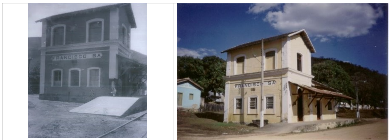
Figuras 15 e 16 – Estação Ferroviária de Francisco Sá, nos anos 1940 e 1990. Fonte: www.estacoesferroviarias.com.br
