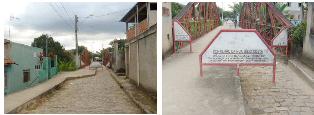
Figuras 29 e 30- Pontilhão à Rua Júlio Costa em Teófilo Otoni. Fonte: Dossiê de tombamento do bem cultural.
