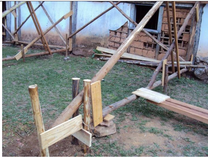
Figuras 04 a 07 – Escoramento de alvenarias.
