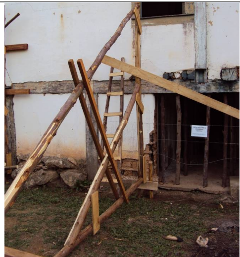
Figuras 04 a 07 – Escoramento de alvenarias.
