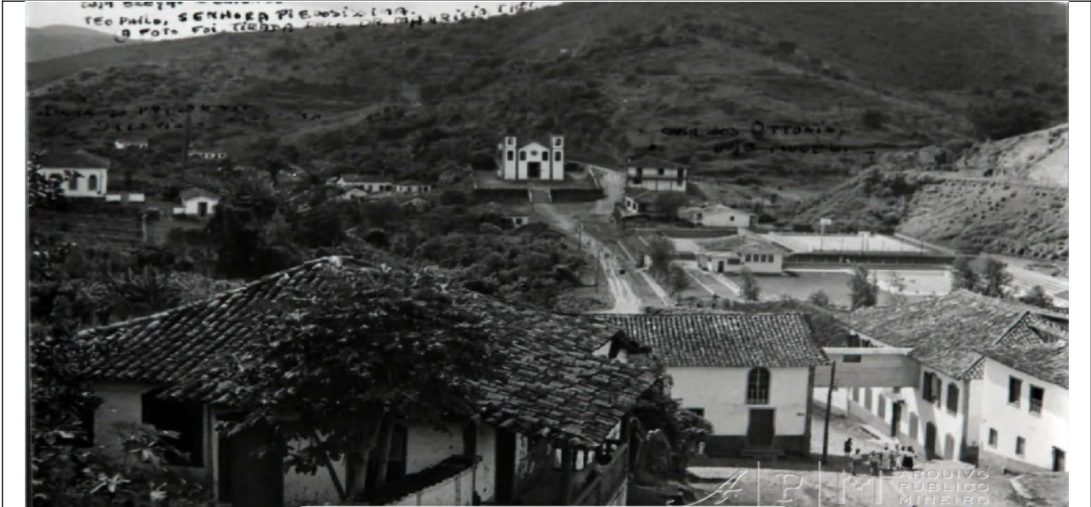
Figura 05 –Vista parcial da cidade do Serro (1957). Ao fundo a Igreja de Bom Jesus do Matozinhos e a Casa dos Otoni. Fonte: http://www.siaapm.cultura.mg.gov.br . Acesso abril 2013.
