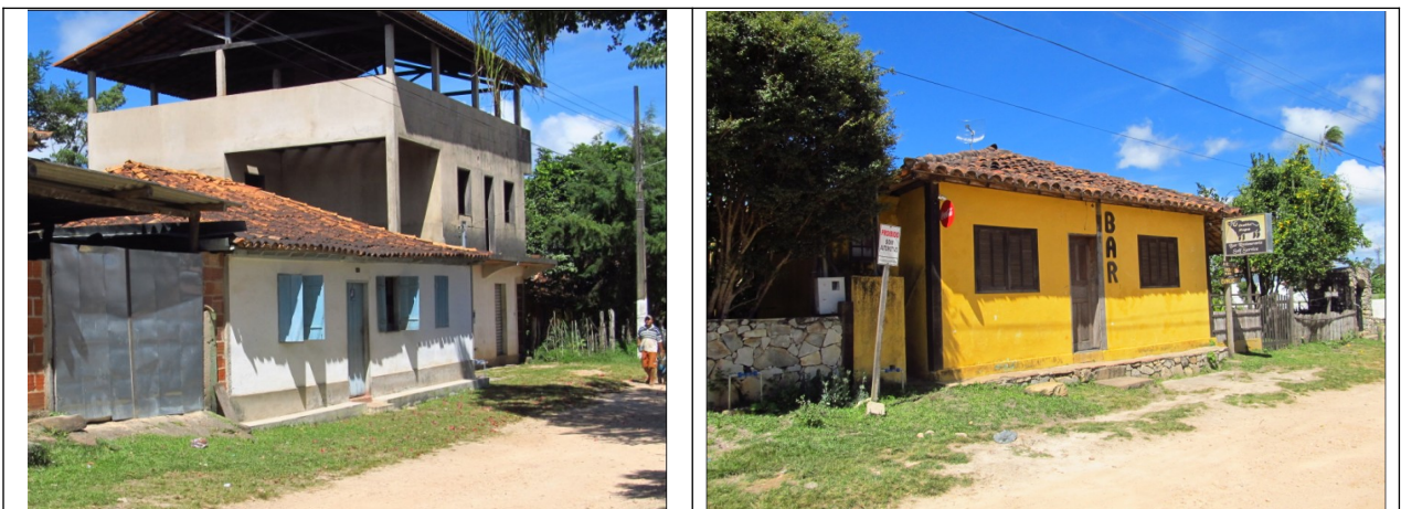
Figuras 19 e 20- Bens culturais inventariados na Rua do Rosário em Milho Verde: Residência nº 100 e Bar Ovelha Negra, nº 80, respectivamente. Foto da vistoria.
