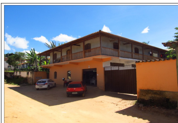
Figuras 25 e 26- Edificação localizada no Beco dos Prazeres, bem próxima à Igreja de Nossa Senhora dos Prazeres. Foto da vistoria.
