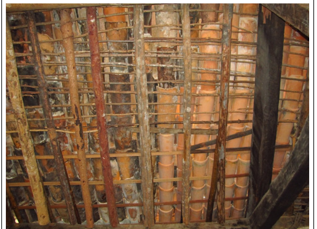
Figura 13 – Substituição de telhas originais por exemplares similares.
