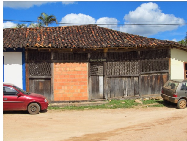
Figuras 07 e 08 – Rancho de Tropas, onde verifica-se a substituição dos elementos originais de madeira por tijolos cerâmicos furados. Foto da vistoria.
