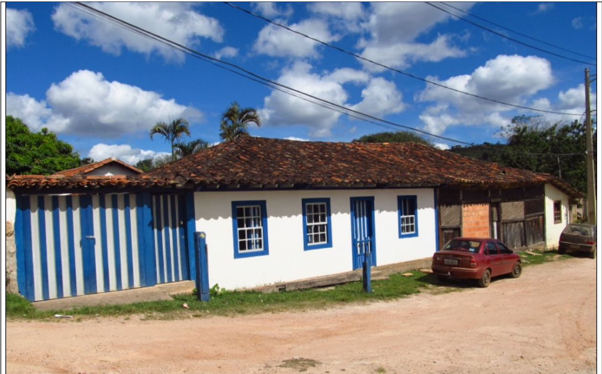
Figura 06 – Rancho de Tropas associado a uma edificação residencial. Foto da vistoria.
