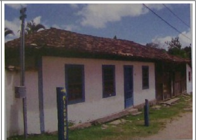
Figura 04 – Rancho de Tropas. Fonte: Inventário de Proteção ao Acervo Cultural do Serro.
