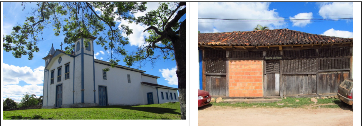
Figuras 09 e 10- Bens culturais tombados em São Gonçalo do Rio das Pedras: Igreja Matriz de São Gonçalo e Rancho das Tropas, respectivamente. Fotos da vistoria.
