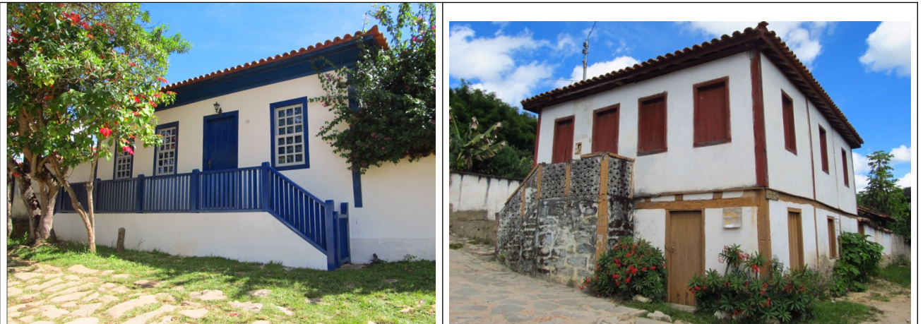
Figuras 17 e 18- Residências a serem inventariadas em São Gonçalo do Rio das Pedras. Fotos da vistoria.
