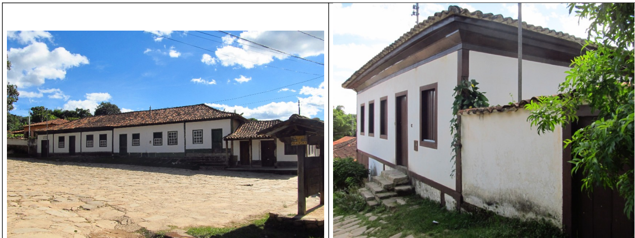
Figuras 11 e 12- Bens culturais inventariados em São Gonçalo do Rio das Pedras: Residência da Praça do Comércio, nº 24 e residência da Rua da Ladeira, nº 67, respectivamente. Fotos da vistoria.
