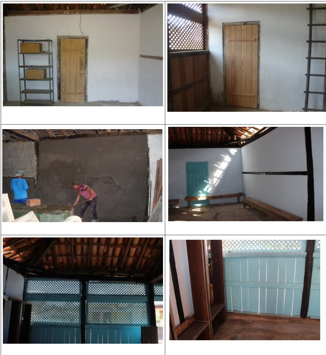
Figuras 13, 14, 15, 16, 17, 17, 19 e 20- Sequência de imagens evidenciando mudanças nas alvenarias do Rancho das Tropas. Fonte: Vistoria realizada em 2013, Relatório Fotográfico da obra de Recuperação e Restauro do bem cultural e imagens encaminhadas pela Promotoria do Serro.
