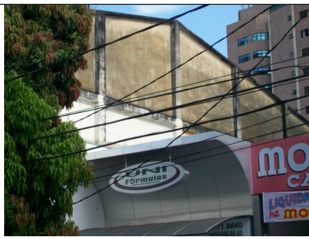
Figura 10 – Trecho da fachada lateral.
