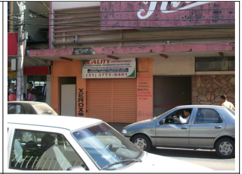
Figura 08 – Vista de uma das lojas na lateral do imóvel, que contribui com a sua descaracterização.
