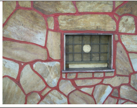
Figura 07 – Bilheteria e parede com revestimento de pedras.
