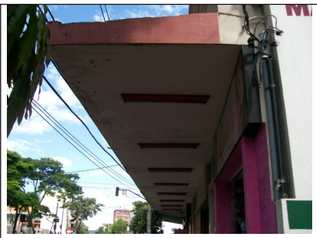
Figura 09 – Marquise sobre calçada.
