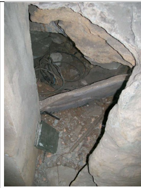
Figura 17 – Fiação aparente.
