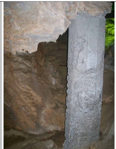
Figura 31 – Pilar de concreto.
