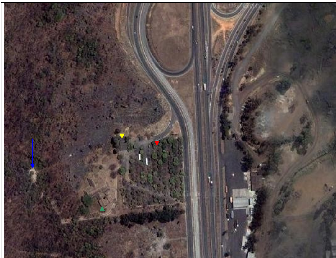
Figura 02 - Vista aérea. A seta vermelha aponta o estacionamento, a amarela o complexo da recepção turística, a verde a edificação com obras paralisadas e a azul a entrada da gruta.
