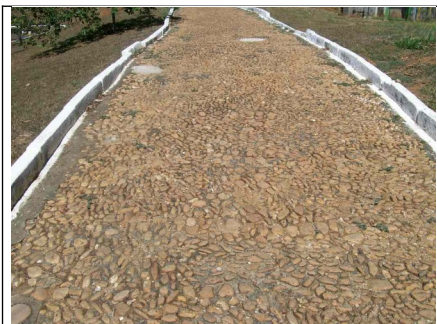
Figura 06 – Caminho de acesso à gruta, com revestimento de seixos rolados.
