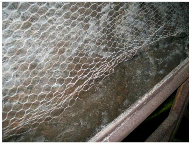
Figura 33 – Tela de proteção .
