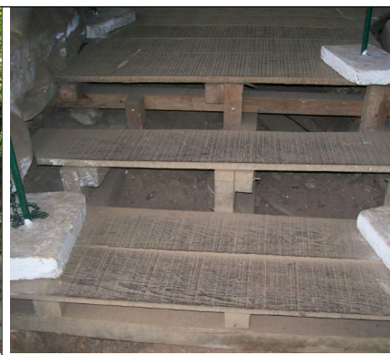
Figura 39 – Escada de acesso.
