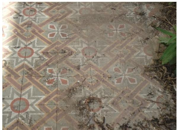
Figura 23 – Piso da calçada lateral – ladrilho hidráulico.
