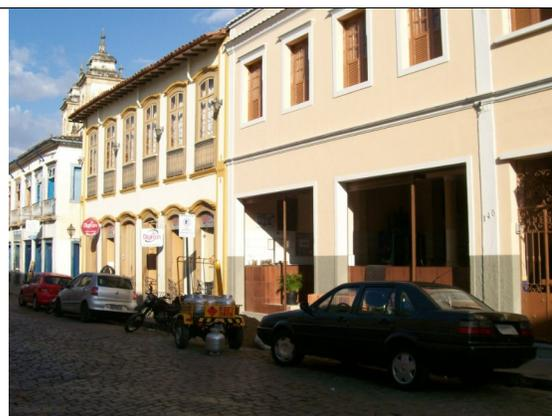
Figura 18 – Descaracterização de edificação na rua Getúlio Vargas. Para adequação do espaço comercial foram substituídas as pequenas portas existentes por portas de enrolar metálicas.
