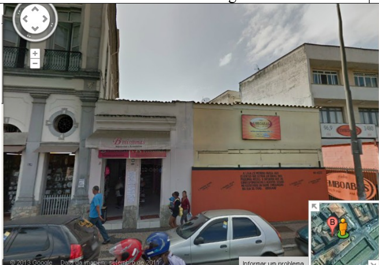
Figura 12 – Imagem do local onde está sendo erguida a nova edificação. Fonte: Googlemaps – acesso em 09/04/2013.
