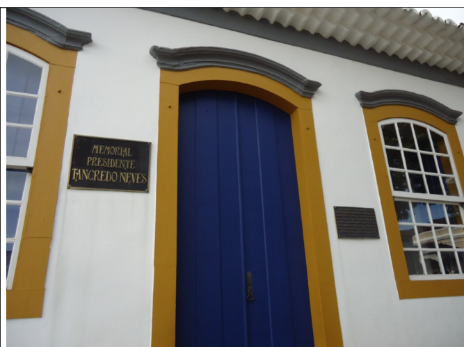
Figura 02 – Placas nas laterais da porta principal do edifício.
