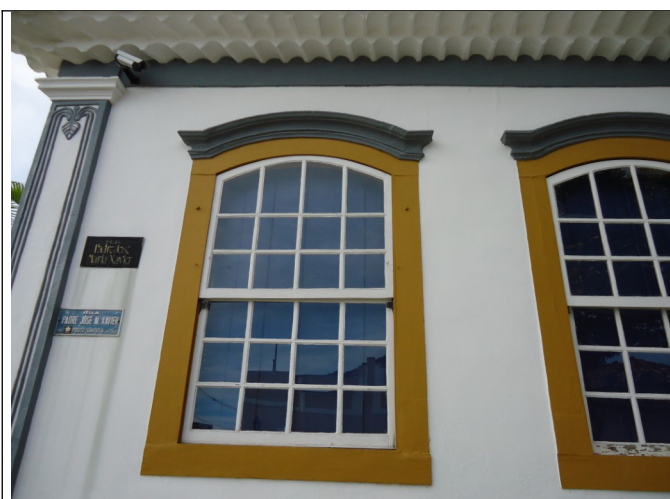
Figura 01 – Placas junto ao cunhal na lateral esquerda do imóvel.
