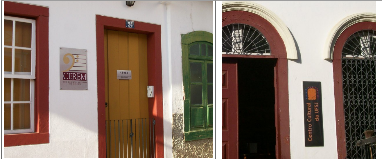
Figuras 30 e 31 – Placas de aço inox paralelas à fachada.
