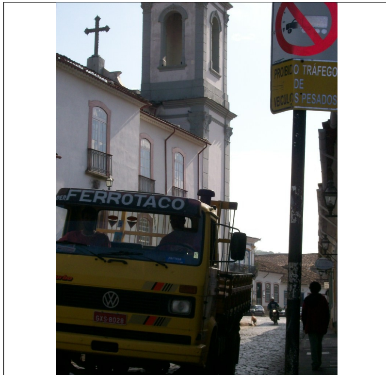
Figura 23 – Caminhão circulando no núcleo histórico, no entorno da Igreja do Rosário, junto à placa de sinalização.
