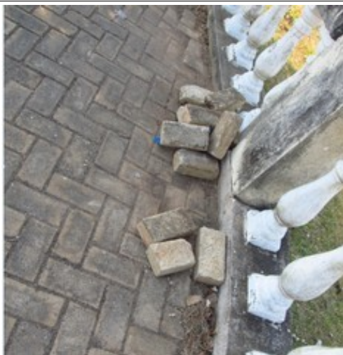
Figuras 14 e 15- Danos na pavimentação no entorno do Monumento Cristo Redentor. Fotos da vistoria.
