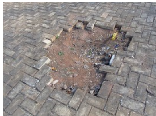
Figuras 14 e 15- Danos na pavimentação no entorno do Monumento Cristo Redentor. Fotos da vistoria.
