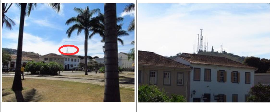
Figuras 2 e 3- Antenas instaladas no Morro do Cristo vistas do Centro Histórico de São João Del Rei. Fotos da vistoria realizada em 25.7.18.
