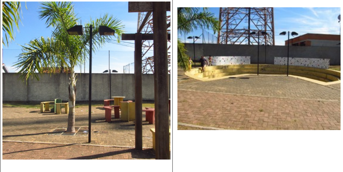
Figuras 19 e 20- Postes de iluminação existentes no entorno do Monumento Cristo Redentor. Fotos da vistoria.
