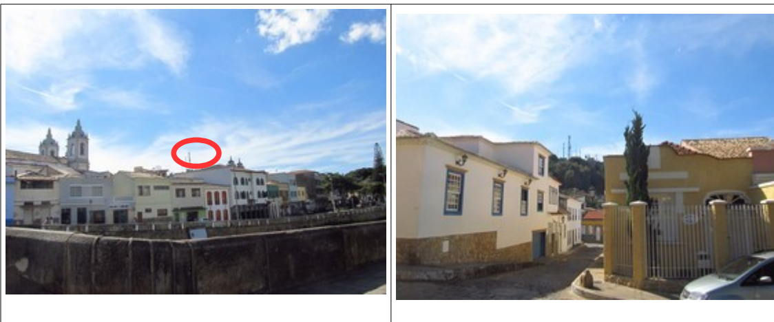
Figuras 4 e 5-Antenas instaladas no Morro do Cristo vistas de diversos pontos do centro de São João Del Rei. Fotos da vistoria realizada em 25.7.18.
