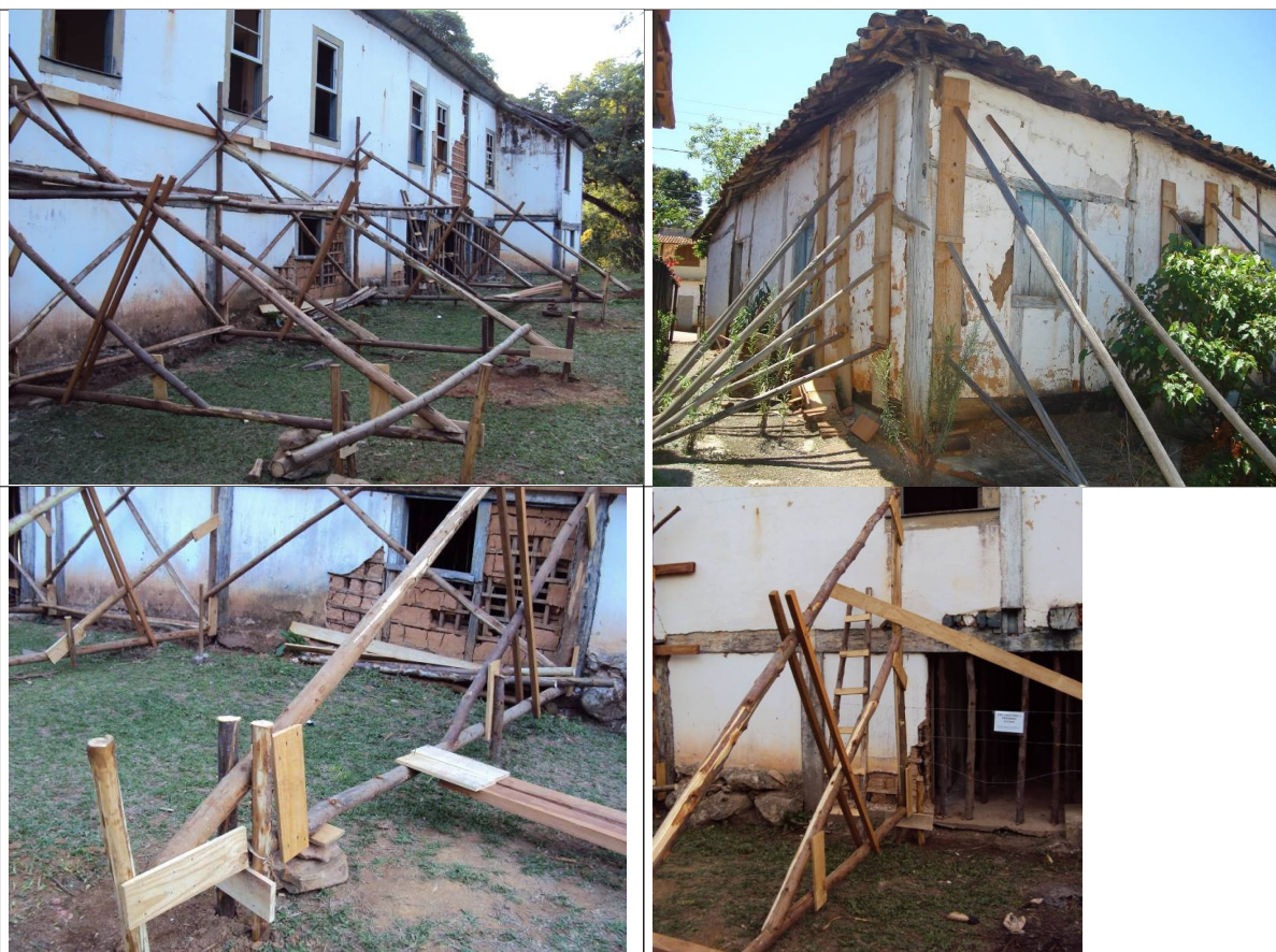
Figuras 04 a 07 – Escoramento de alvenarias.
