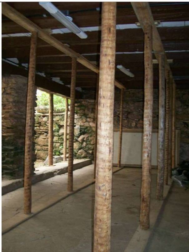
Figura 9 – Esquema para escoramento das peças de madeira do telhado, do piso (através do porão) e
