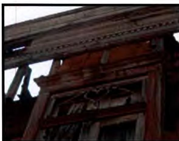
Elementos decorativos em madeira das esquadrias da fachada e dos interiores, além de cimalha do guarda-pó da fachada se deterioraram pela ação das intempéries. Paredes em adobe estão em processo de desmoronamento.
