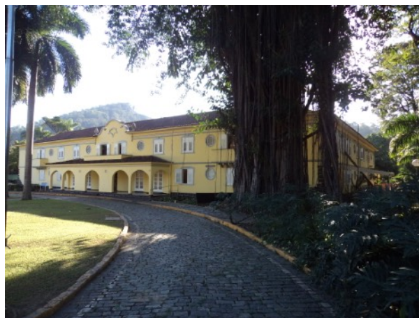
Figura 10 – Fundação Acesita. Fonte: Promotoria de Patrimônio Cultural – vistoria 26 de agosto.
