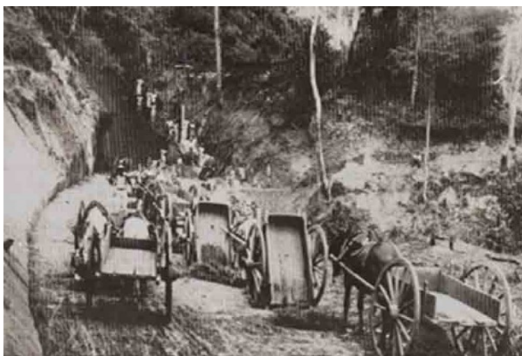
Figura 3 - Obras de terraplanagem para a construção da Estrada de Ferro
