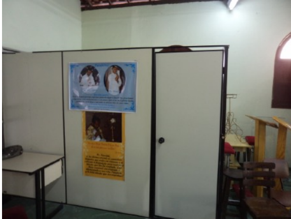
Figura 46 – Verifica-se no canto direito da fotografia a existência de objetos acumulados. Fonte: Promotoria de Patrimônio Cultural – vistoria 26 de agosto.
