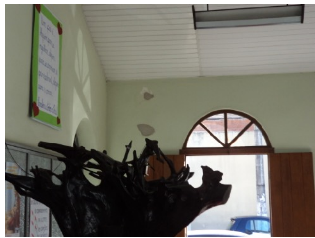
Figura 41 – Preenchimento de área de perda do reboco com argamassa de cimento. Fonte: Promotoria de Patrimônio Cultural – vistoria 26 de agosto.
