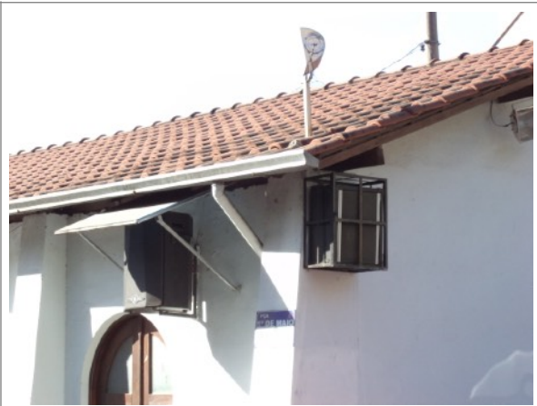
Figura 53 – Caixas de som instaladas na área externa do templo. Fonte: Promotoria de Patrimônio Cultural – vistoria 26 de agosto.
