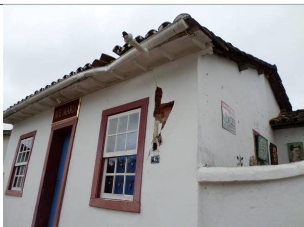
Figuras 05 e 06 – Arandela de iluminação pública existente em edificação na rua Direita que foi atingida por caminhão de grandes dimensões, danificando a edificação na qual se encontrava instalada.
