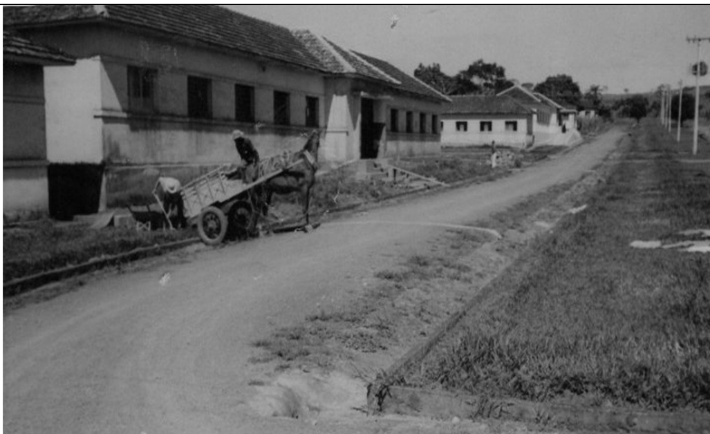
Figura 9 - Vista externa da construção da Colônia São Francisco de Assis. Fonte: foto enviada por e-mail pelo Núcleo de Ensino e Pesquisa da Casa de Saúde São Francisco de Assis. Acesso em: 20-02-2017.
