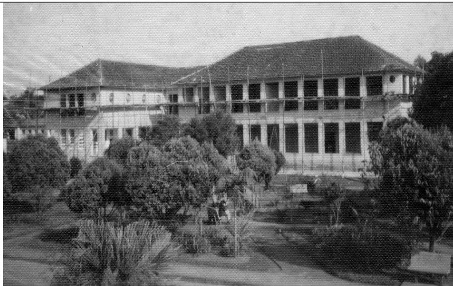
Figura 7 - Vista externa da construção da Colônia São Francisco de Assis. Fonte: foto enviada por e-mail pelo Núcleo de Ensino e Pesquisa da Casa de Saúde São Francisco de Assis. Acesso em: 20-02-2017.
