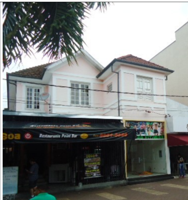
Figura 03 – Imagem atual da edificação.
