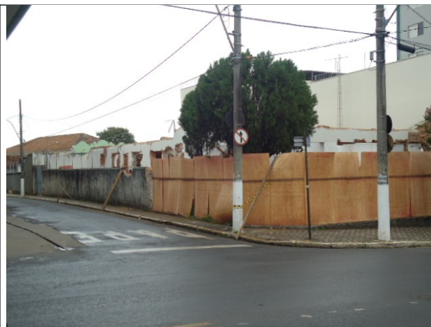
Figura 06 – Edificação vizinha, em processo de demolição.
