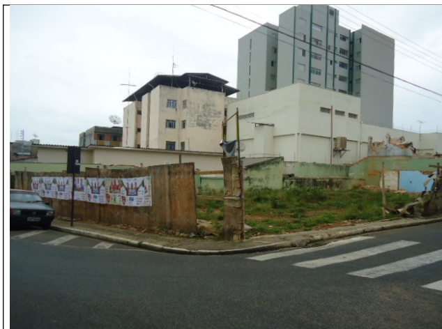
Figura 05 – Imagem atual do terreno, após a demolição do imóvel.
