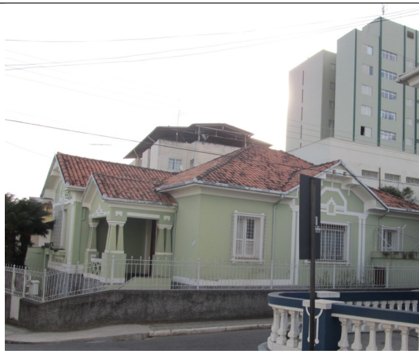
Figura 04 – Imagem da edificação antes da demolição.
