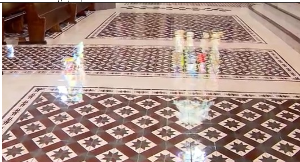
Figura 03 – Piso foi trocado mantendo preservando os desenhos originais.
