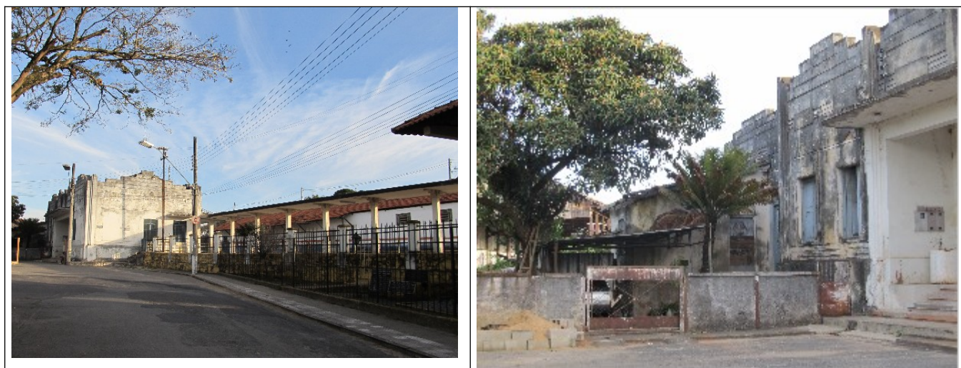
Figuras 12 e 13 – Imagem da estação, plataforma e cobertura de garagem anexa ao prédio.
