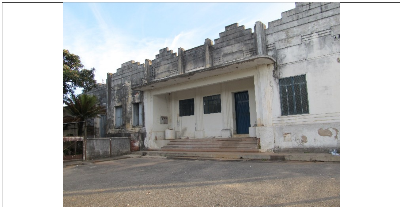
Figura 11- Fachada frontal da Estação Ferroviária de Três Corações, imóvel tombado pelo município.
