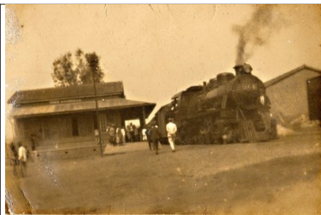
Figura 05 – Imagem anterior a 1945 que mostra o prédio antigo da estação e o trem a vapor. Fonte: www.estacoesferroviarias.com.br .
