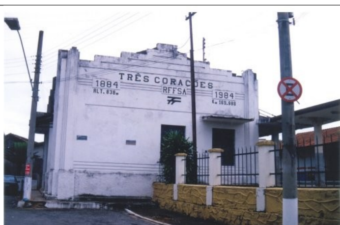
Figura 08 – Estação em 2005. Fonte: www.estacoesferroviarias.com.br .
