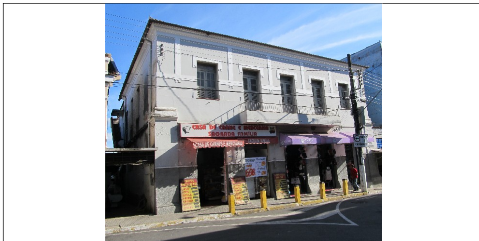
Figura 22- Imóvel situado na Rua Sagrado Coração de Jesus, nº 40 e 34.
