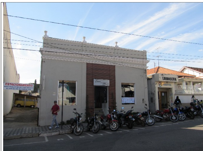
Figura 10- Imóvel situado na Avenida Getúlio Vargas, nº 409.
