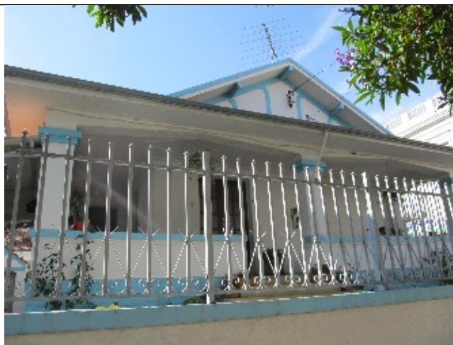
Figura 12 - Imóvel situado na Avenida Getúlio Vargas, nº 449.
