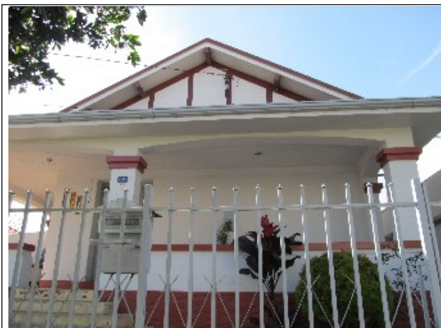
Figura 11- Imóvel situado na Avenida Getúlio Vargas, nº 435.
