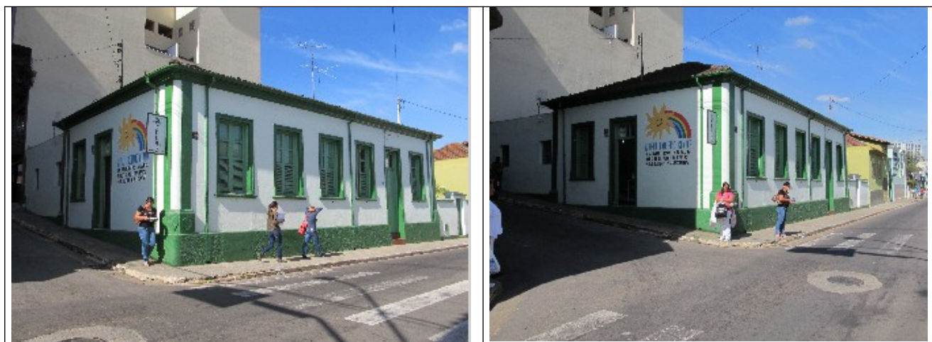
Figuras 05 e 06- Imóvel situado na Rua Presidente Dutra, nº 100 em Três Corações.
