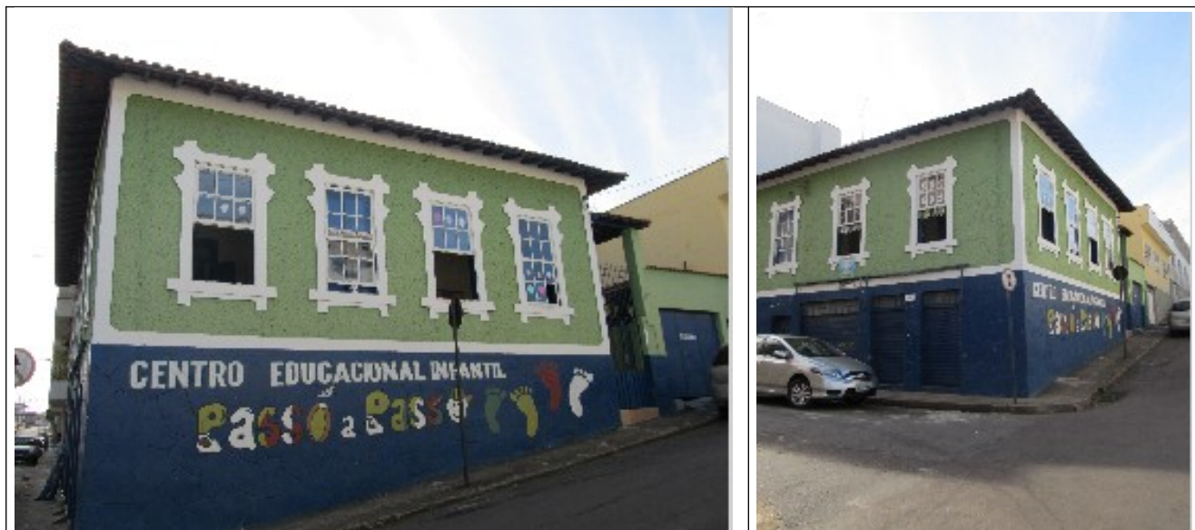
Figuras 16 e 17- Imóvel situado na Rua Azaías Florêncio Pereira.
