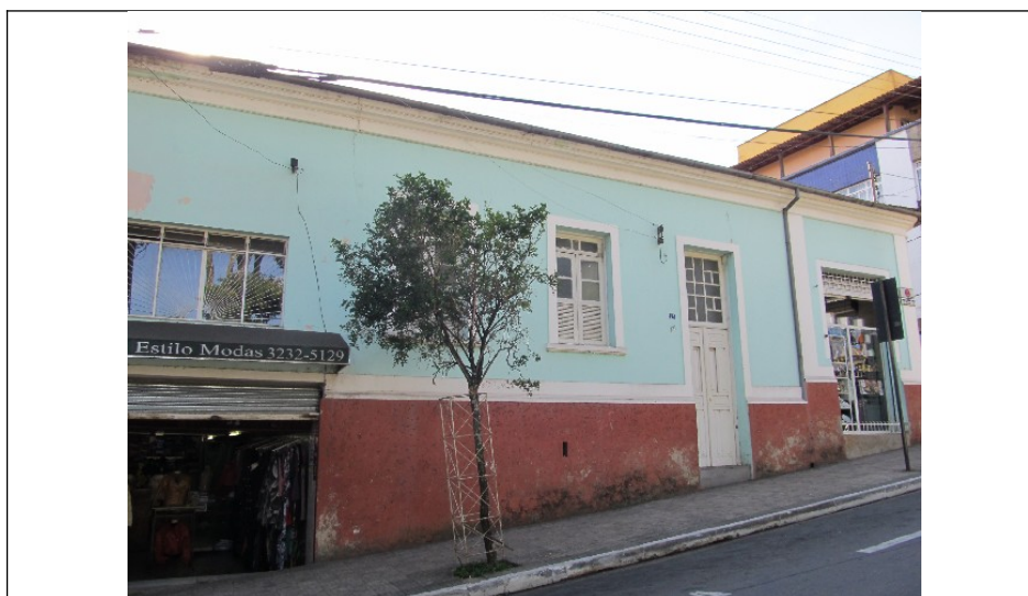
Figura 13- Imóvel situado na Praça Zeferino Avelar, nº 27, 3 e 40
