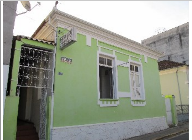
Figura 21- Imóvel situado na Rua Casemiro Avelar, nº 174
