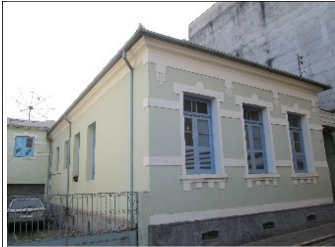
Figuras 20 e 21- Imóvel situado na Rua Casemiro Avelar, nº 164
