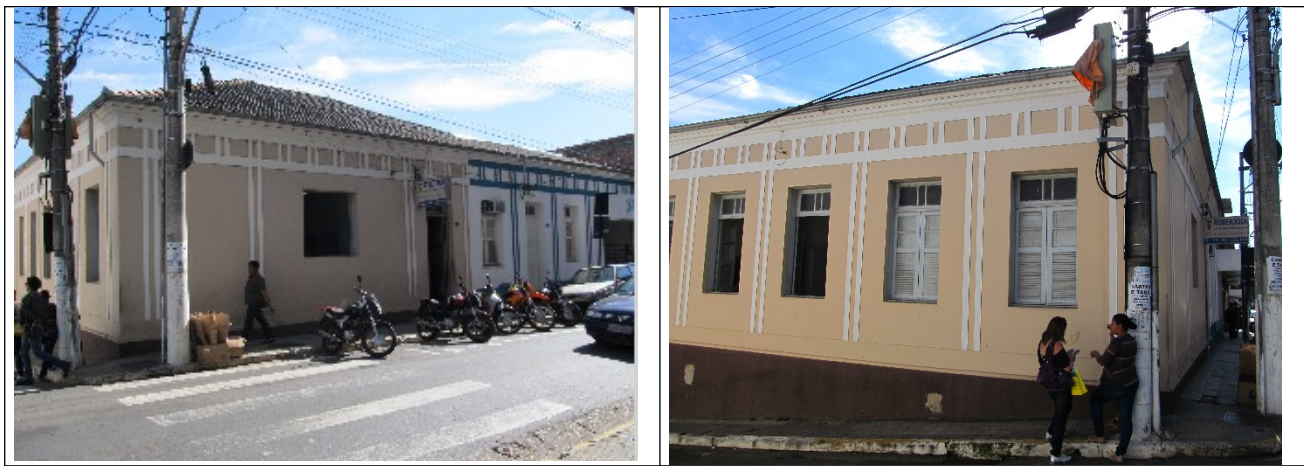
Figuras 07 e 08- Imóvel situado na Rua Presidente Dutra, nº 121, 125, esquina com a Rua Pedro Bonésio.
