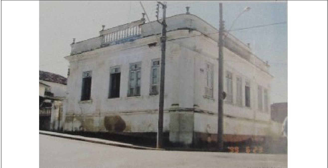
Figura 04- Imóvel inventariado em Três Corações. Fonte: Ficha de inventário pesquisada junto ao IEPHA.
