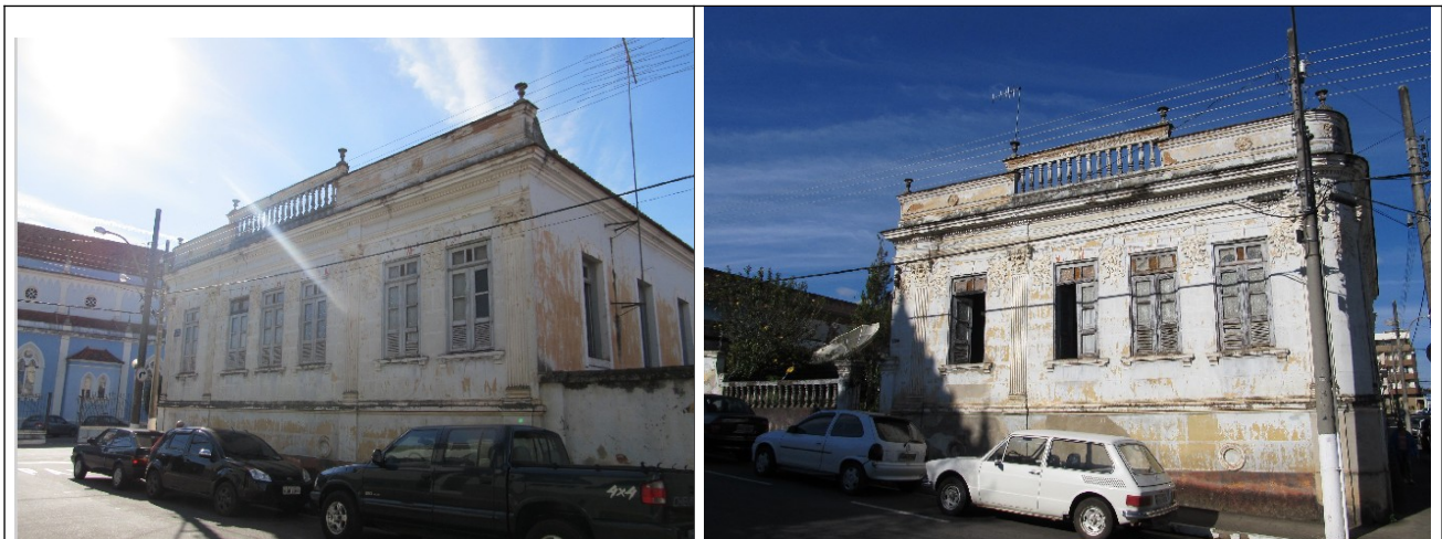
Figuras 06 e 07- Imagens do imóvel inventariado localizado na Praça Cônego Zeferino, nº 80, em Três Corações.
