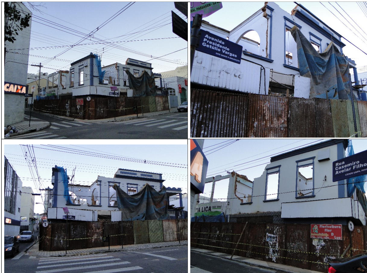
Figura 05, 06, 07 e 08- Imagens da demolição da casa de Zequinha Avelar em Três Corações. Fonte: Documentação fotográfica encaminhada a esta Promotoria
